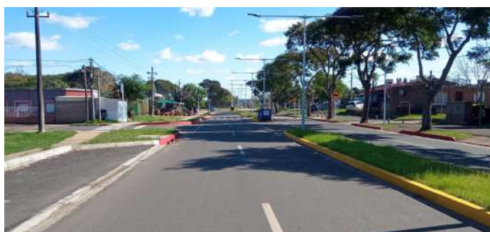
Figura 3: Tramo 2 al OE. Tramo 1
