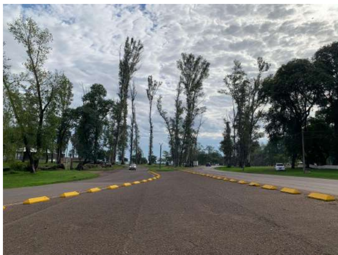
Figura 4: Av. Costanera Norte
