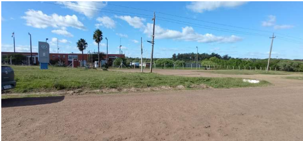
Figura 6: Planta de Tratamiento de OSE
